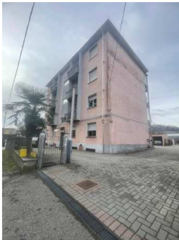
Foto 1: Vista esterna dell'immobile Foglio 11 Particella 695
