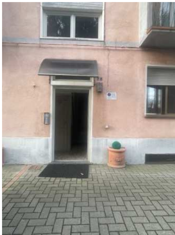
Foto 5: : Vista esterna dell'immobile Foglio 11 Particella 695
