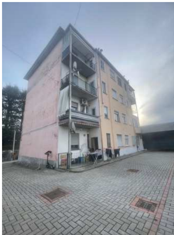
Foto 2: : Vista esterna dell'immobile Foglio 11 Particella 695
