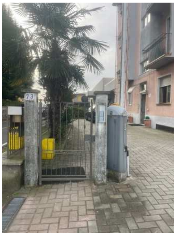
Foto 4: : Vista esterna dell'immobile Foglio 11 Particella 695
