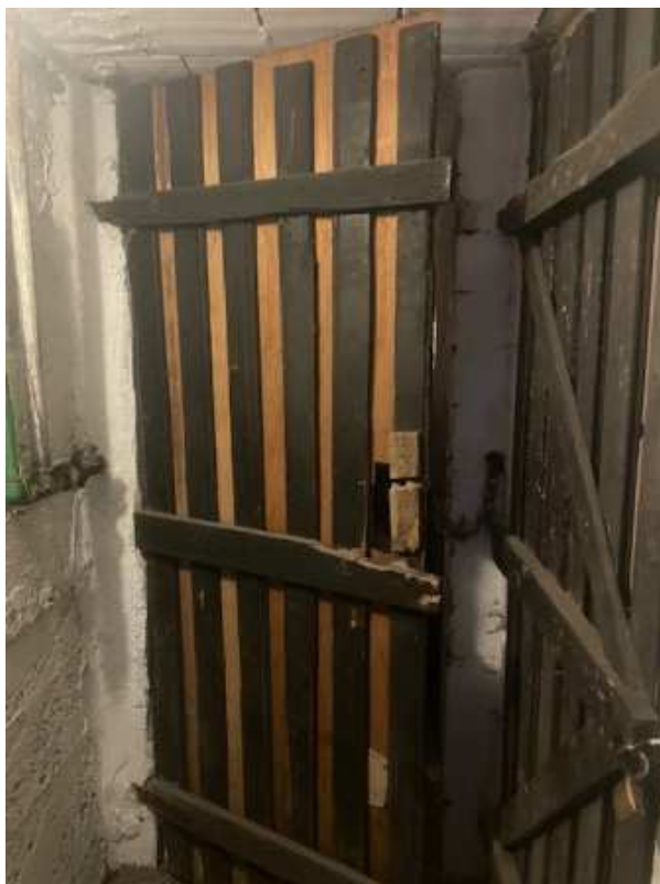
Foto 21: Vista interna dell'immobile (Cantina) Foglio 11 Particella 695 Sub. 2
