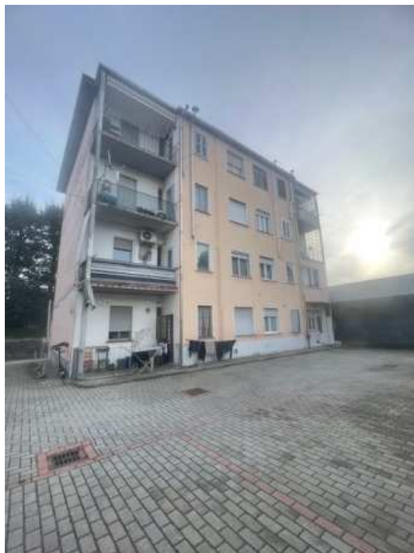
Foto 3: : Vista esterna dell'immobile Foglio 11 Particella 695
